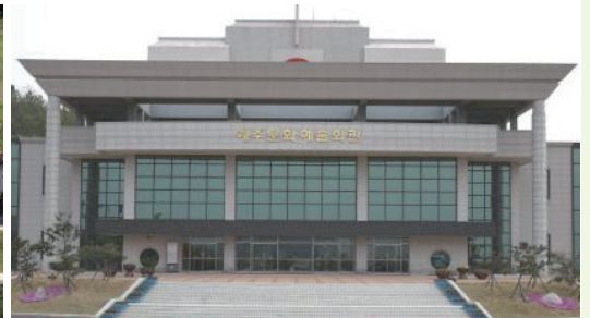
예주문화예술회관 | 경상북도 영덕군 영해면 318만세길 36
