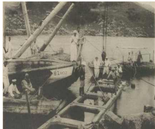
<그림-26> 남방파제 공사(1933.7.24)
