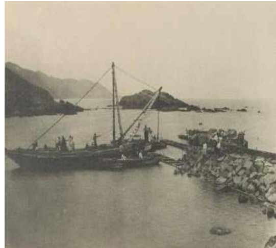
<그림-24> 남방파제 공사(1933.7.24)
